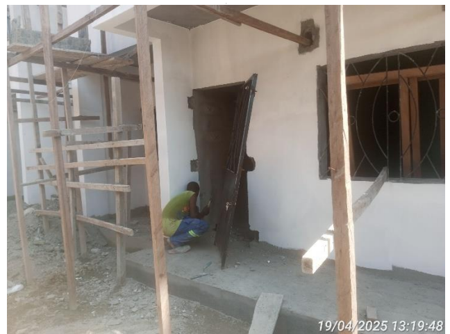
Photo 2 : Pose des portes métallique de 90 x 220
