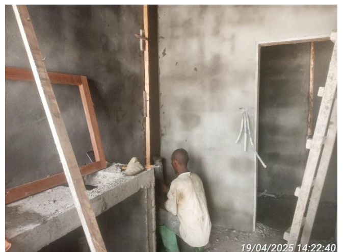
Photo 5 : Enduit sur murs intérieur (T2).
